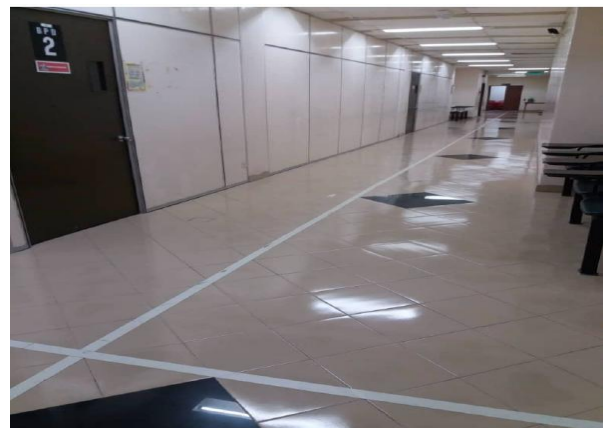
Lantai yang bersih, selamat dan tidak rosak
