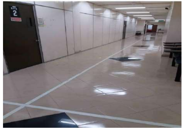
Lantai yang bersih, selamat dan tidak rosak
